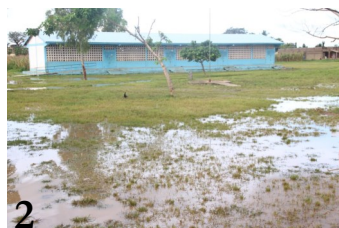
Photo 2 : Cas d'inondation au CEG Ewaiyo (Binah 2) le 29/09/2026
