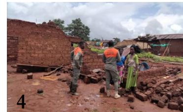
Photo 4 : Dégâts liés aux vents violents à Kouï dans la commune de Blitta 3 le 17/09/2026
