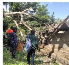
Photo 3 : maison détruite à Yikpa-Dzigbe dans la commune de Danyi I le 30/08/2026
